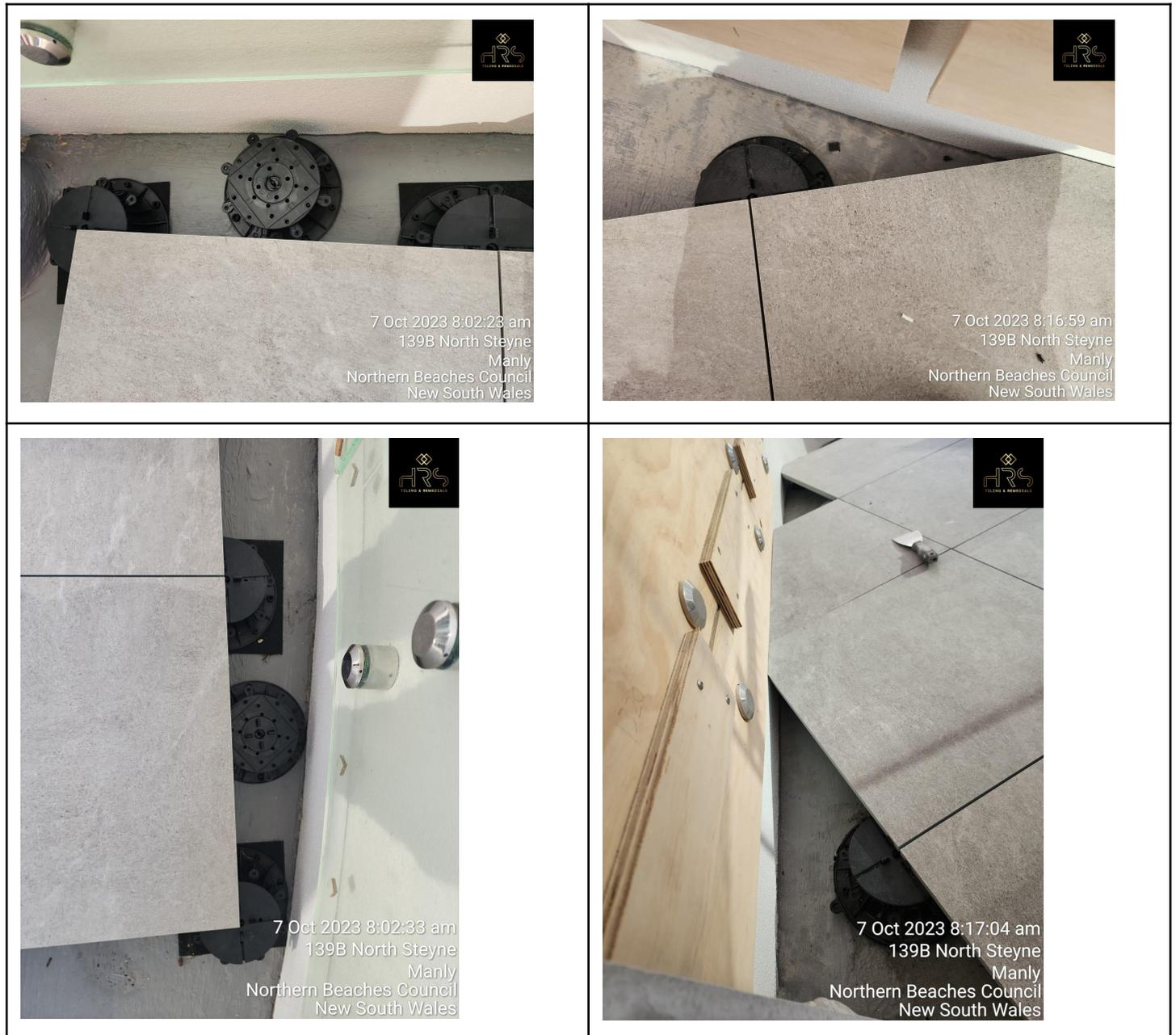
Reducción del diámetro de la base y del cabezal ajustable.
