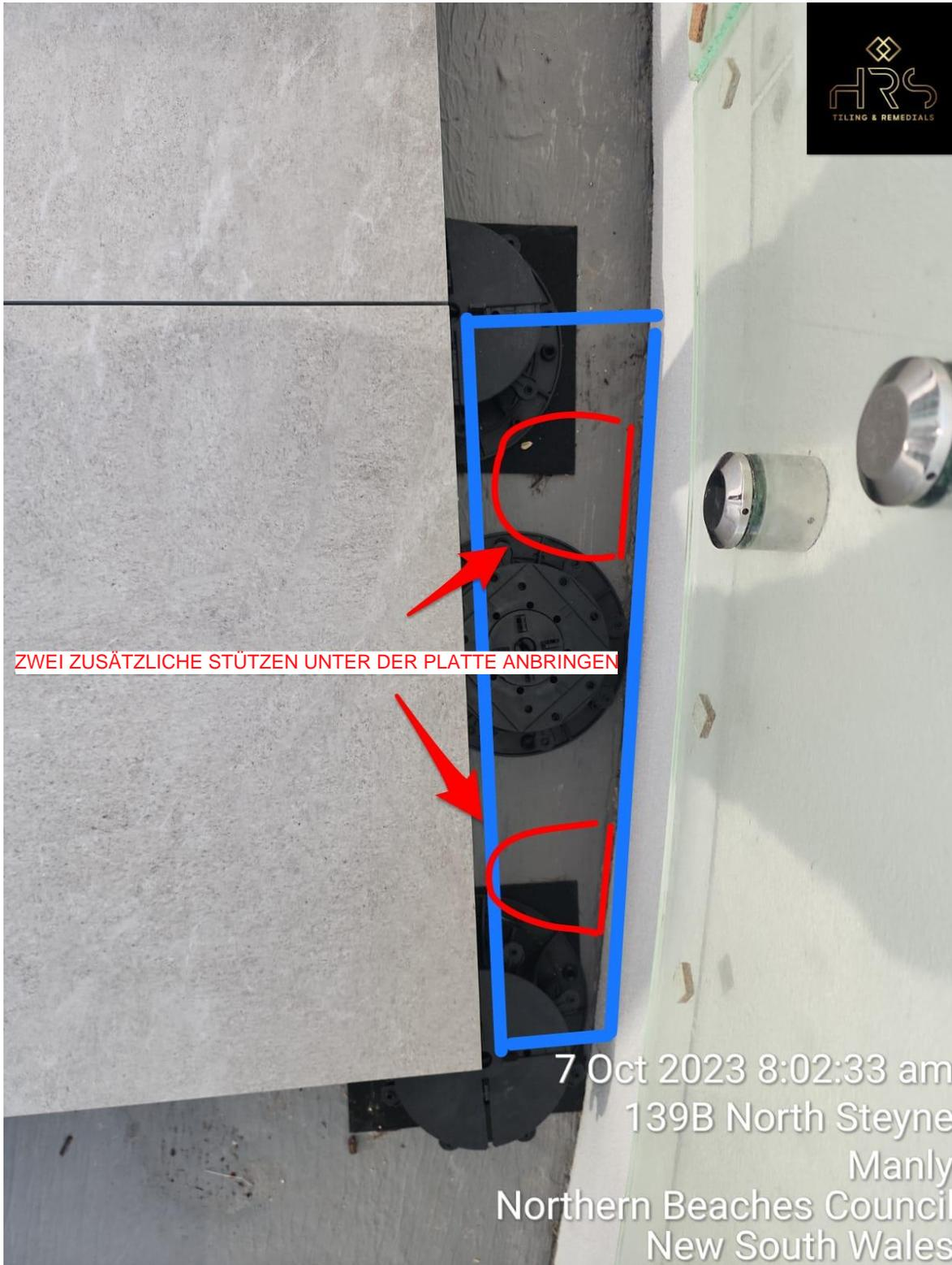
Verwendung eines anderen Stelzlager - mit kleinerem Sockel und Kopf.
