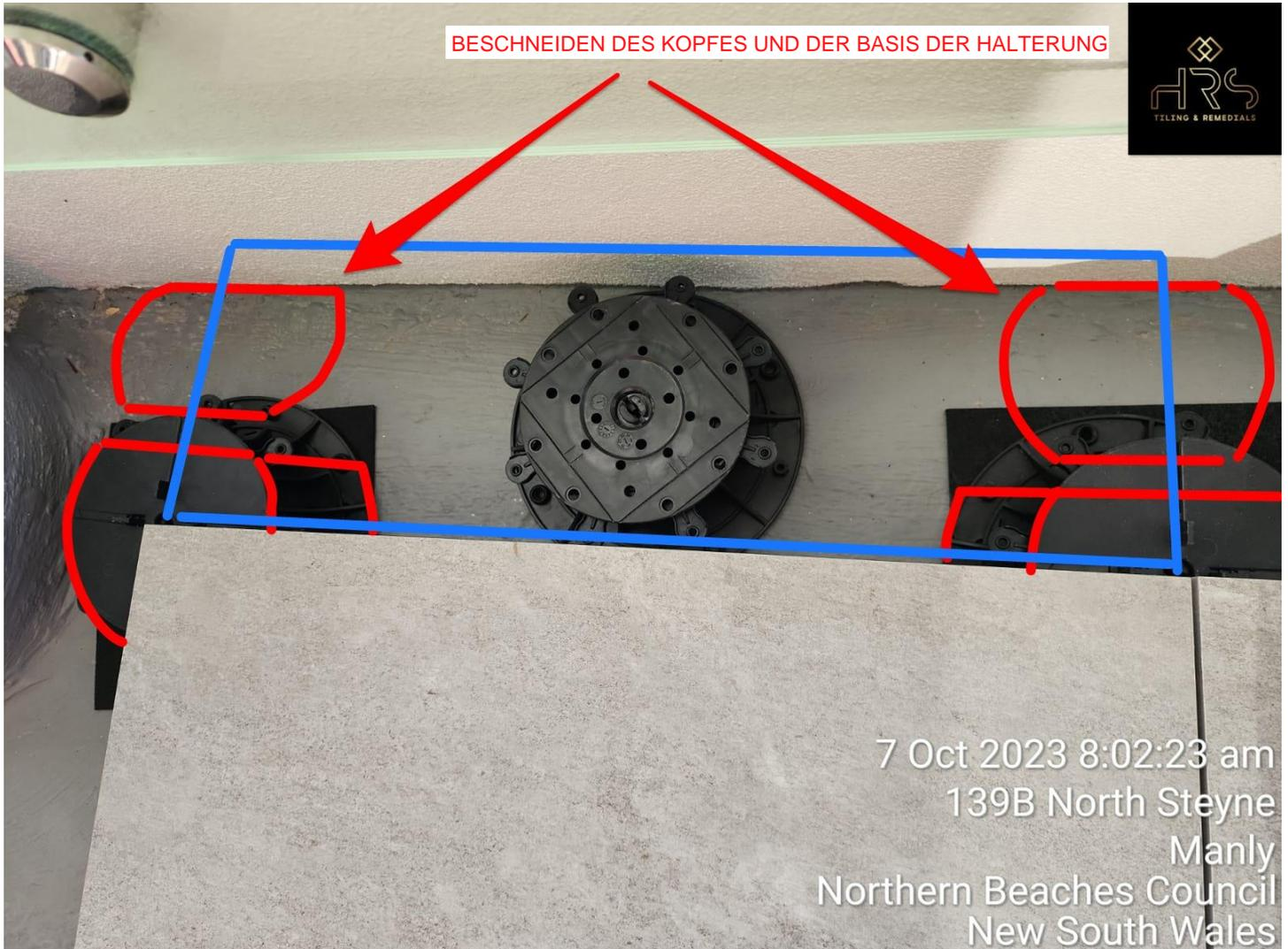
Verwendung von mehr verstellbaren Stelzlager unter der Terrasse.
