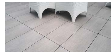
Terrasses en dalles
